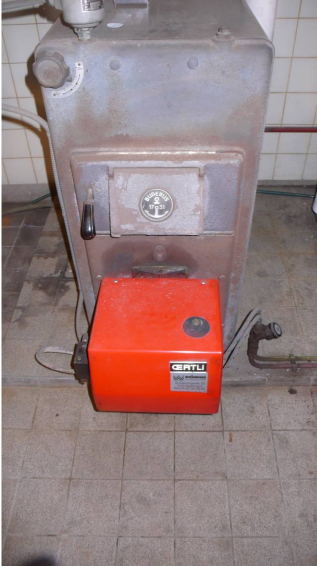
Bestandsaufnahme Bsp: Kessel von 1954
