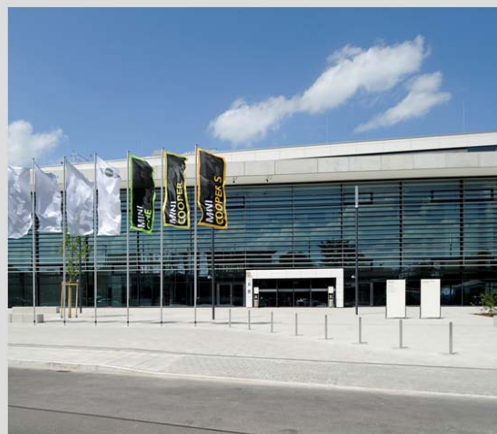
Projekthalt: Neubau Informationstechnologiezentrum Planungs- und Bauzeit: 2006-2009
