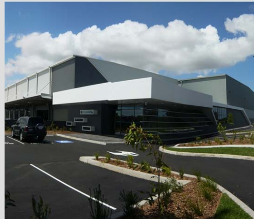
Projekthalt: Neubau Regionales Distributionszentrum Sydney Planungs- und Bauzeit: 2006-2008
