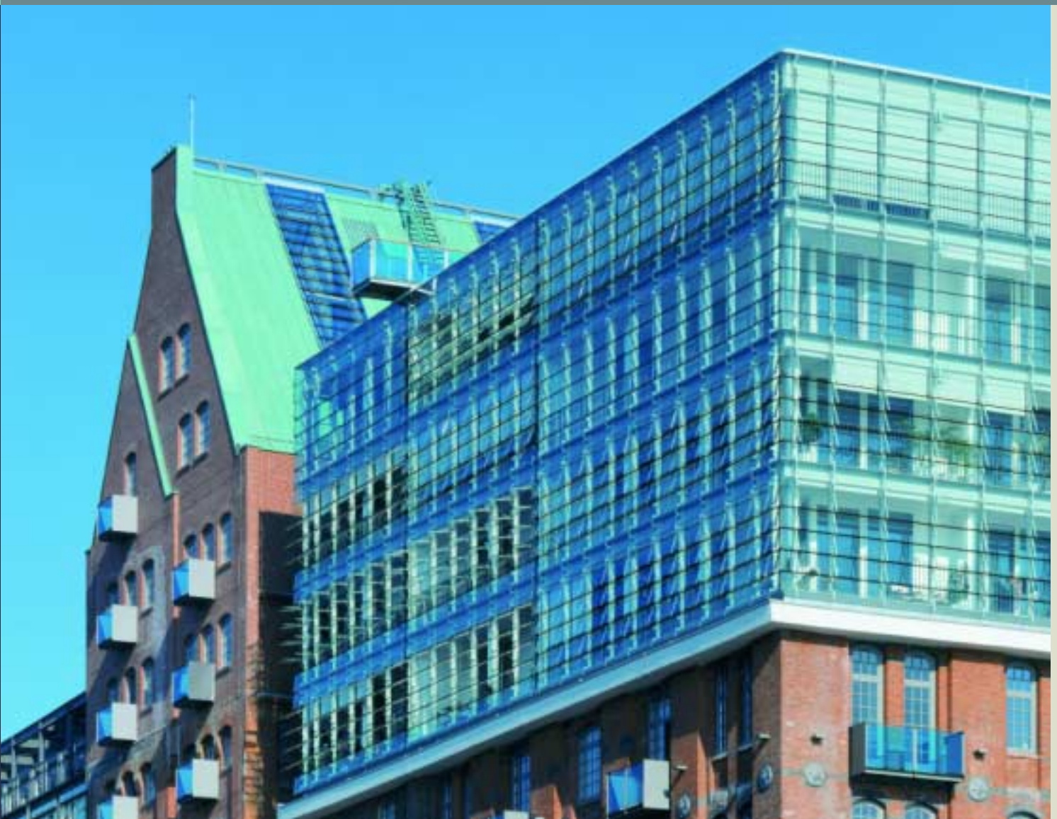
Stadtlagerhaus Hamburg. Jan Störmer Architekten, Hamburg
