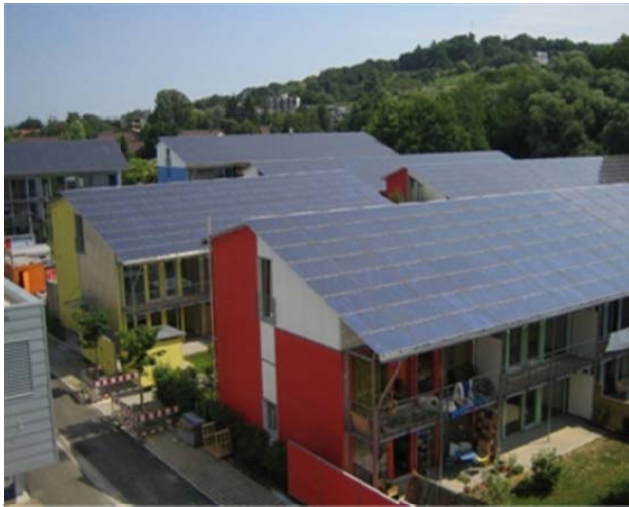
Plusenergiesiedlung Freiburg. Überdimensionierte Photovoltaik-Anlagen und Nahwärme mit regenerativem Wärmeanteil. Architektur Rolf Disch, Freiburg
