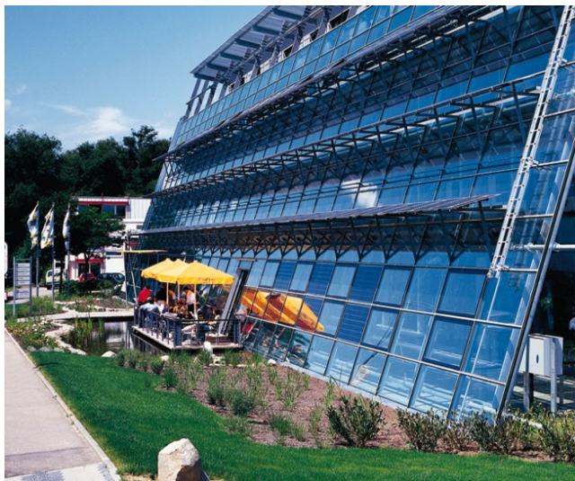
Solar-Fabrik Freiburg, erstes vollständig solar versorgtes Fabrikgebäude weltweit. Solare Energieversorgung mit Rapsöl-BHKW, Photovoltaik-Anlagen und passiver Sonnenenergienutzung. Architektur Rolf + Hotz, Freiburg
