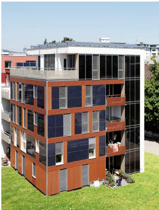
Nullemissionshaus elementar, Tübingen. Holzpelletheizung und thermische und photovoltaische Solaranlagen. Architektur ARGE Sonnenmoser, Riedel, Schlierf, Tübingen
