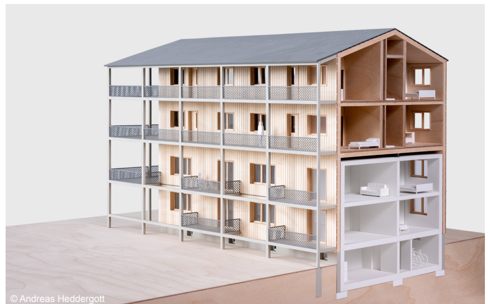
Abb. 6 Tragwerkkonzepte der Baugruppe Transferebene: Typ Hybrid - Lastenleitung über neue Außenwände und Mittelwand Bestand (oben) und Typ Exo - Lastenleitung nur über neue Außenwände (unten)
