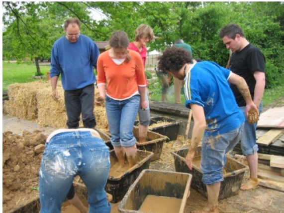
Auf der Baustelle
