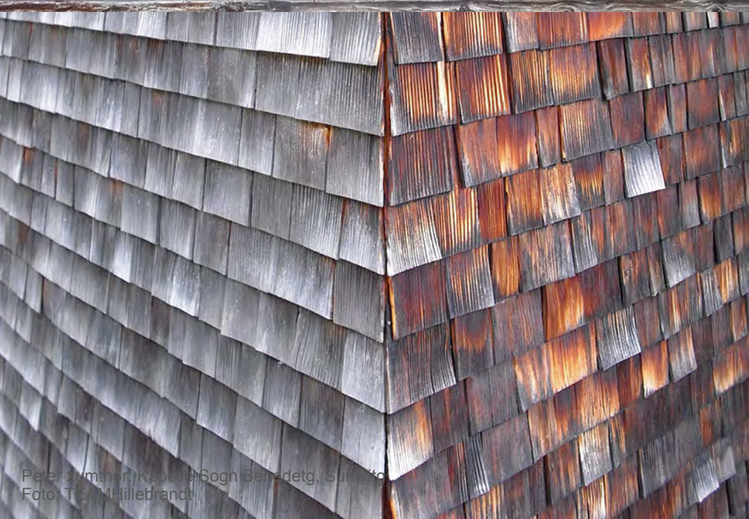
Hochalpen Holzbau in der Schweiz Foto: TEAMHillebrandt
