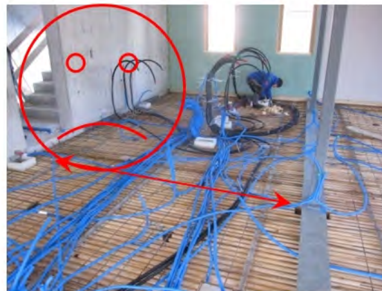
Abbildung 13: Für Leitungsquerungen in Bereichen von Stützen durch die zuständigen Planer frühzeitig kommuniziert wird. (Trittschall-Problematik)
