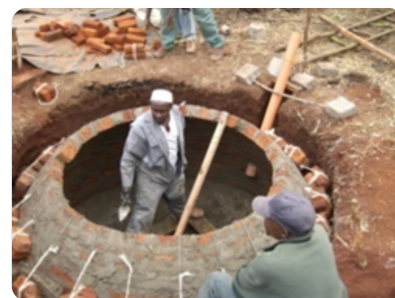
Bau von Biogasanlagen für Haushalte in Kenia
