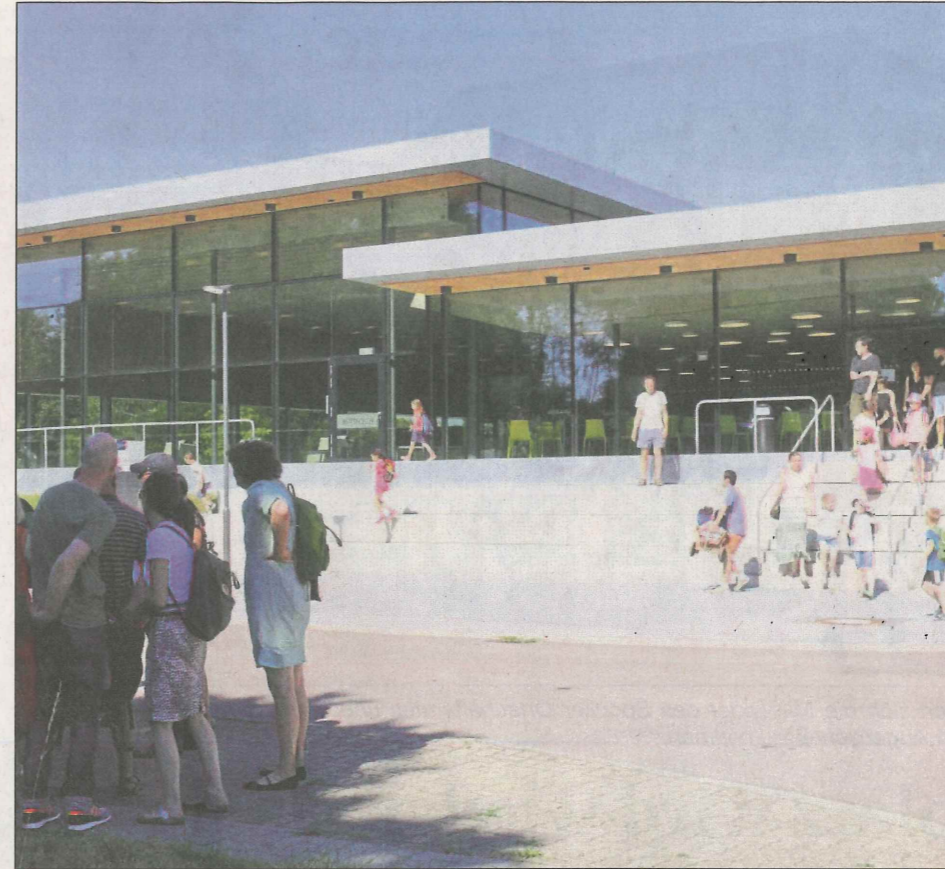
DIE BEIDEN BAUKÖRPER des Stutenseebades in Blankenloch werfen das Gebäude mit seinen großen Glasfronten architektonisch auf. Fotos: Klumpp
