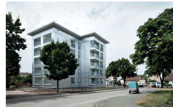
GBG Sanierung Punkthaus Schönau Rudolph-Cleff & Pfeifer Foto: Claudius Pfeifer
