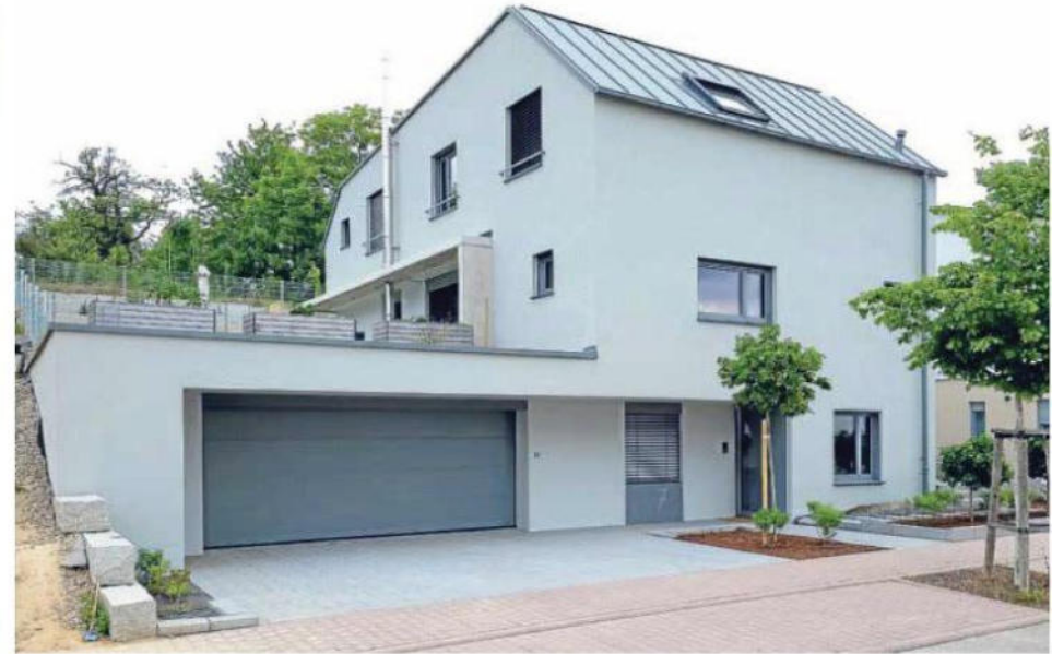
Der Bebauungsplan für das Gelände einer früheren Gärtnerei in Mühlhausen stellte Planung und Errichtung dieses Hauses vor gleich mehrere Herausforderungen.
