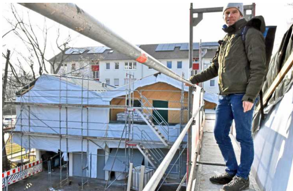
Alles im Blick: Architekt Falk Schneemann begutachtet die Baustelle in Rintheim. Die Bauten sind über Winter noch für einige weitere Wochen in Folie eingepackt. Foto: Stefan Jehle
