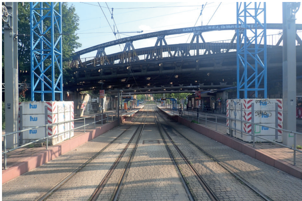
09 Stahlfachwerkbrücken über der Nordbahnhofstraße
