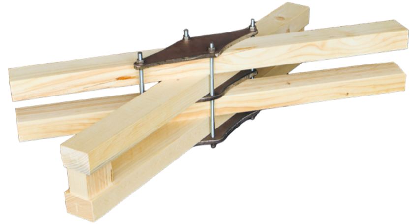
Abb. 11/ oben und ganz oben Modellfotos von 1:1 Knotenpunkte der Gitterschale für verschiedene Winkelanwendungen in der Gitterschale. Eine variable Wiederverwendung der Knoten ist möglich („Auf der Garage“)
