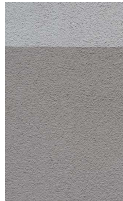
Putzfassade Wohnbau (gegenüber)
