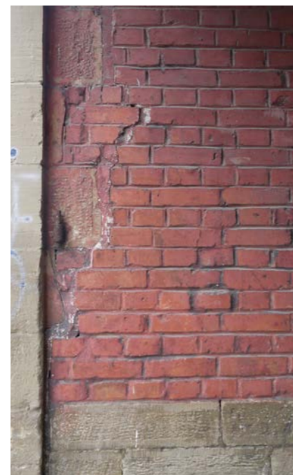
Klinkermauerwerk Gründerzeitbauten (gegenüber)
