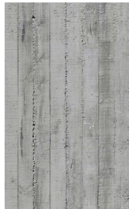
Geschossdecken aus Sichtbeton
