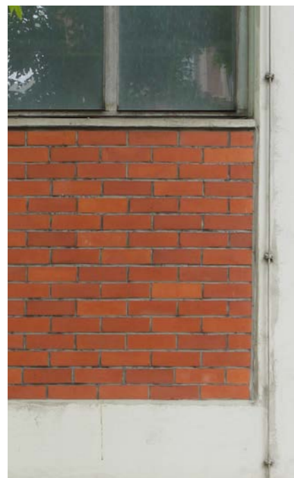
Klinkerausfachung ENBW Gebäude (gepl. Abriss)
