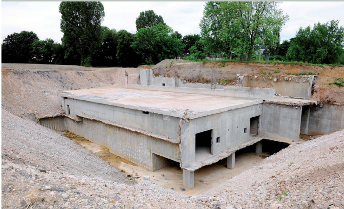
Zisterne im Rohbau
