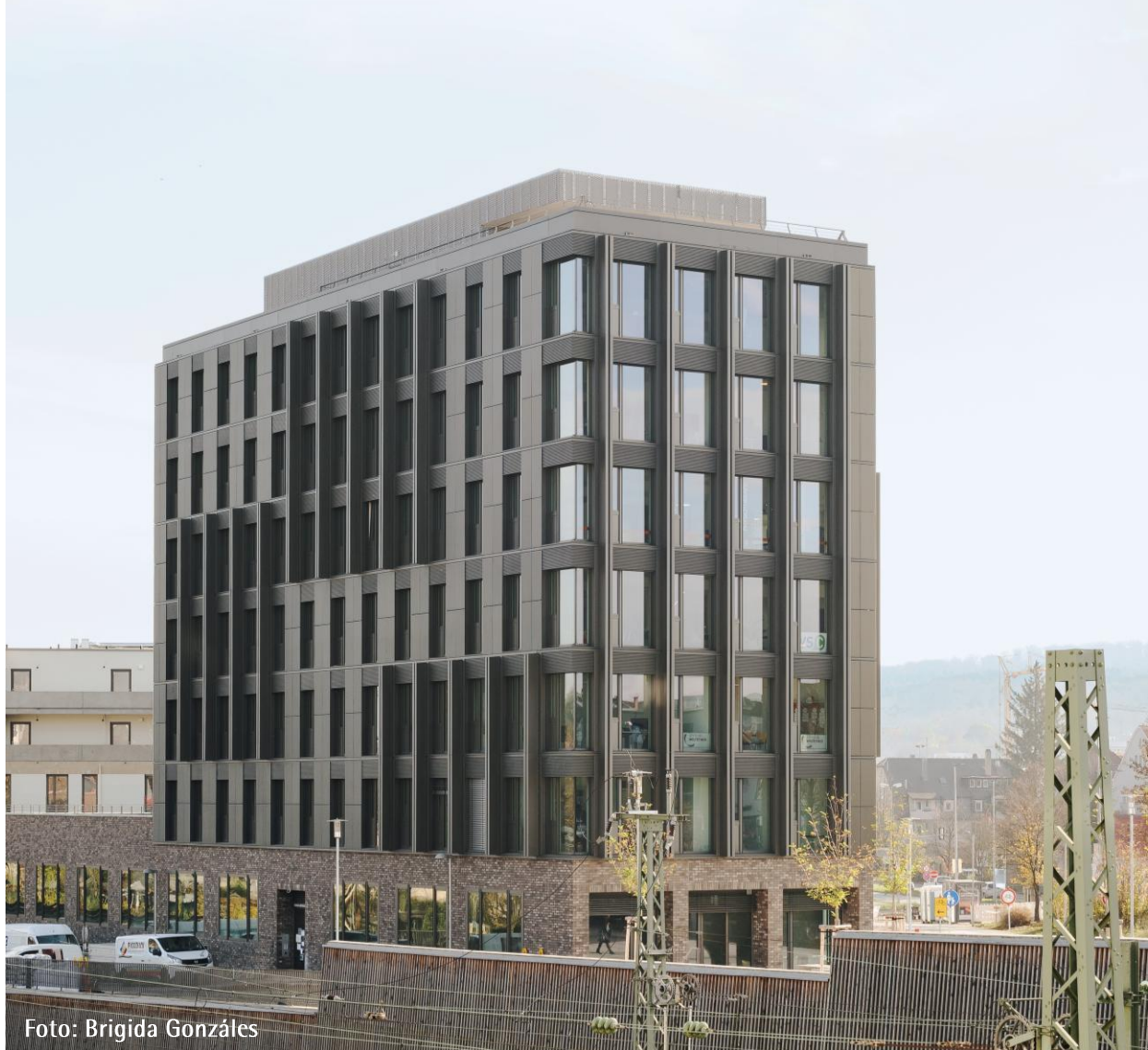
Westspitze Tübingen: Fassade mit CIS-Dünnschicht-Photovoltaik-Modulen
