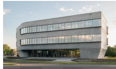
Verwaltungsgebäude Gustav Eppler, Stuttgart
