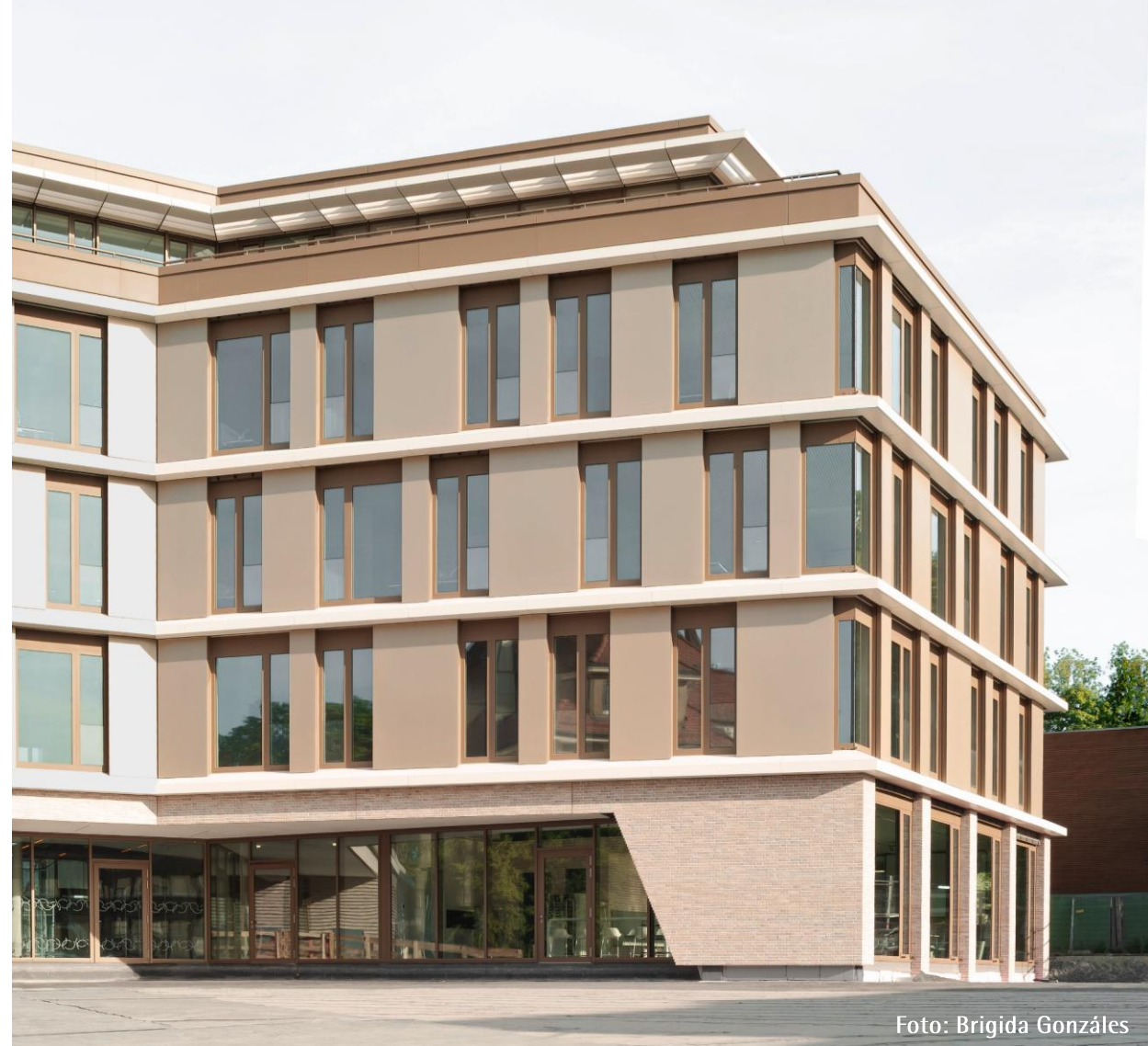
Landratsamt Waiblingen: Fassade mit kristallinen Photovoltaik-Modulen
