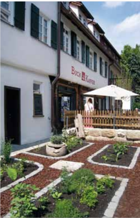
Instandsetzung und Umbau Nonnenhaus Tübingen
