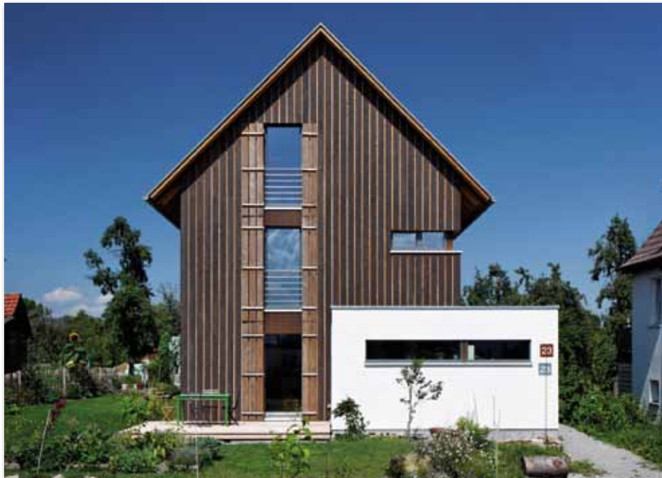
Einfamilienhaus in Holzbauweise Kusterdingen
